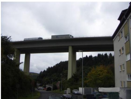
Die A 45 wird in diesem Bereich (**Alte Rheinstraße**) als Talbrücke geführt. Sie weist einseitig eine Verkleidung des Brückengeländers mit einer Kunststoffwand (Spritzschutz) auf, die jedoch nicht durchgängig ausgeführt ist.
