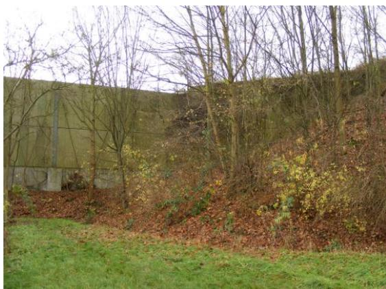
Der Ortsrand ist hier durch Lärmschutzwände mit einer Höhe von 4m bis 6m und einen Lärmschutzwall von 6m Höhe geschützt. Die Abbildung zeigt den Übergang Lärmschutzwand/Lärmschutzwall
